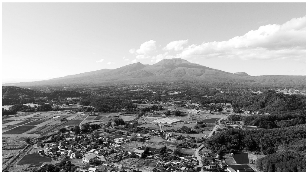
図2 高度約100メートルから空撮した浅間山
